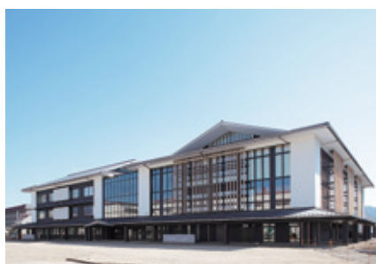
完成した第二中学校
