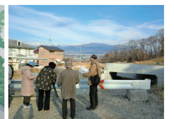
▼ 現在工事が進められています
