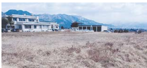
泉田保育園建設現場(後方は給食センター)
