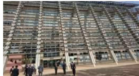
庁舎太陽光パネル設備見学 太陽光パネルは庁舎の日よけの役割を果たしている
