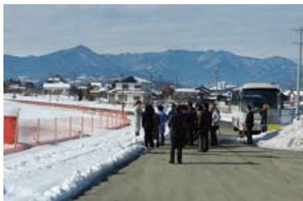
市道川辺町国分線工事現場視察
