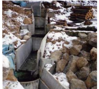
半過「大口水源整備」工事中の水路(26年1月)
