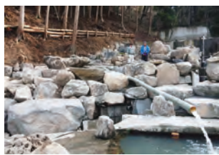
事業完了後の現地と 水路への試し通水
