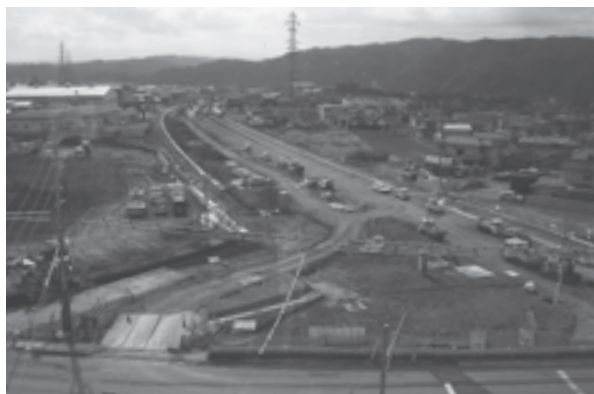
開通に向け工事が進む上田バイパス第二期工区
