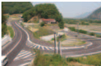
上田坂城バイパス全線開通
