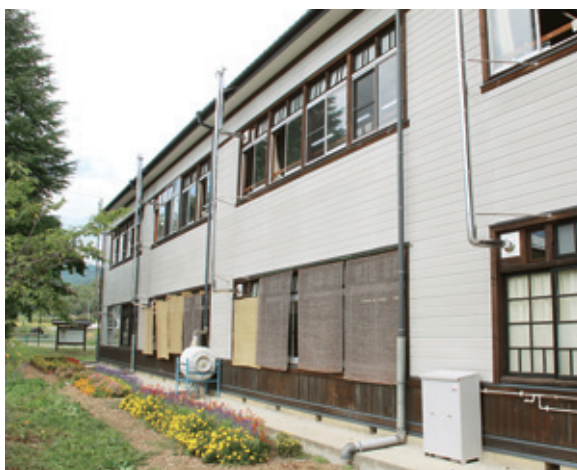
延焼をまぬがれた南校舎で9月10日から学校生活が再開された。
