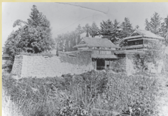
解体前の櫓門（明治10年頃）
