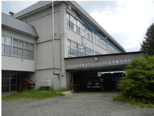
中学校廃校舎を活用した「ペレット工場」
