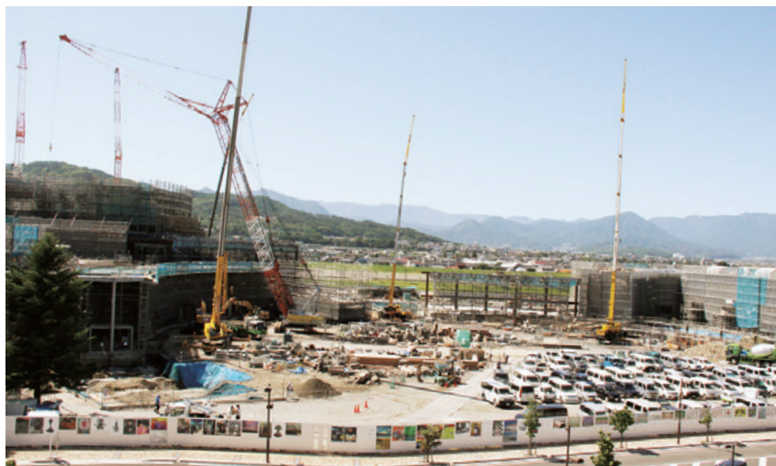
建設地北側(アリオ上田側)からの建設地全景(9月現在)
