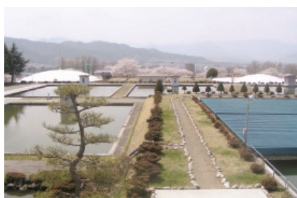
小水力発電を導入を予定する染屋浄水場
