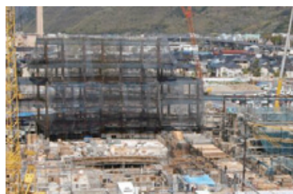
交流・文化施設の工事状況
