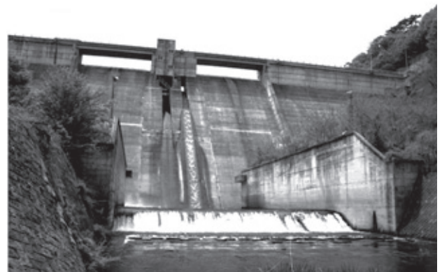
内村ダム(ダム本体に入って見学します)
