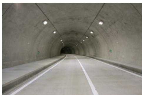
トンネル内部
