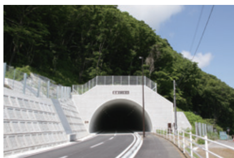
トンネル外観(丸子側)
