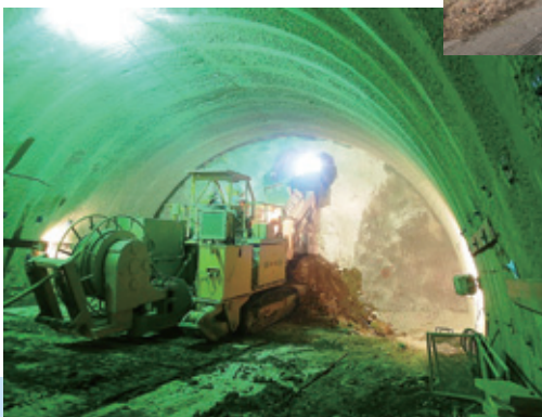
トンネルの貫通
