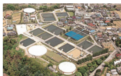
染屋浄水場全景
