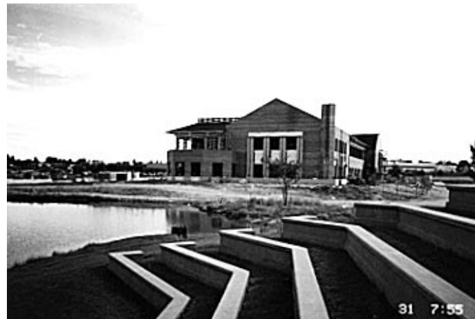
▲現在建設中の新図書館とコミュニティホール
