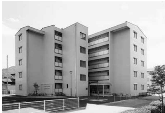
町営住宅で始めてエレベーターを設置した中丸子第2団地
