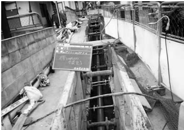
整備が進む下水道工事
