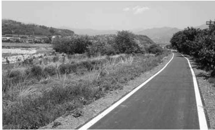
完成した依田川の右岸堤防道路
