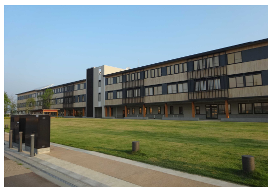
PFI による建設された町庁舎
