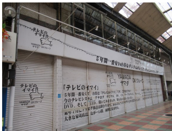
商店街空き店舗リノベーション現地
