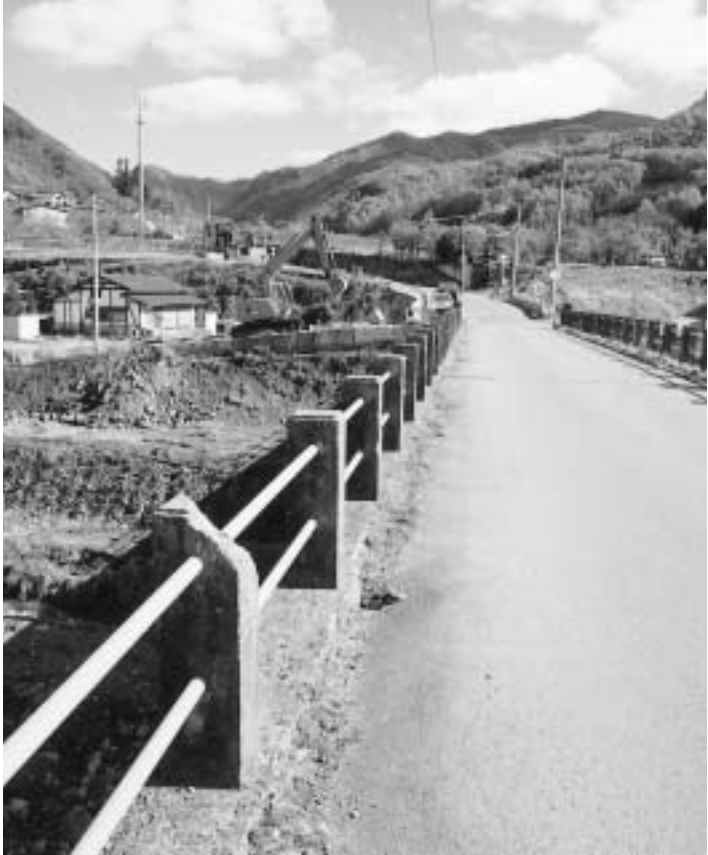
う回路の工事が始まった町道横道大倉線の駒込橋。
