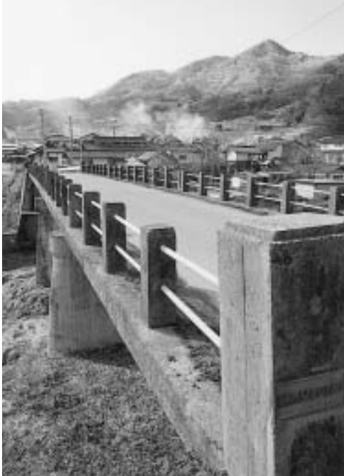
洗馬川を渡る、町道横道大倉線の駒込橋。架け替え工事が行われることに。
