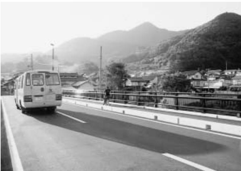
橋長36.2m、車道幅員5.5mで上流側に2.5mの歩道がついた新しい駒込橋。
