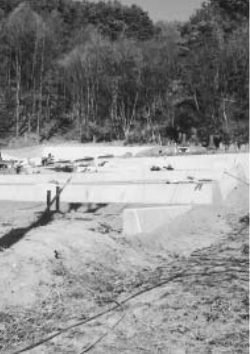
古城緑地広場近くに造成工事中の町営墓地。分譲は、4月5日から始まる。詳細は22ページに掲載。
