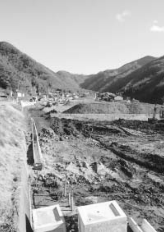
工事が進む三島平工区のほ場整備事業。1月末には面整備が完了の予定。
