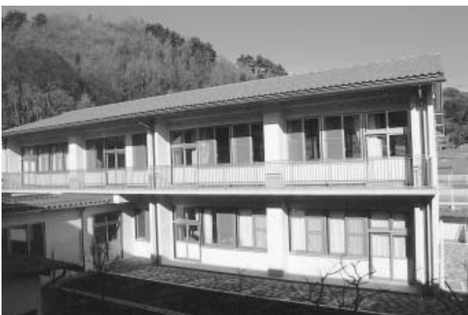
完成した傍陽小学校特別教室棟。パソコン教室、音楽室、図工室、多目的教室がある。
