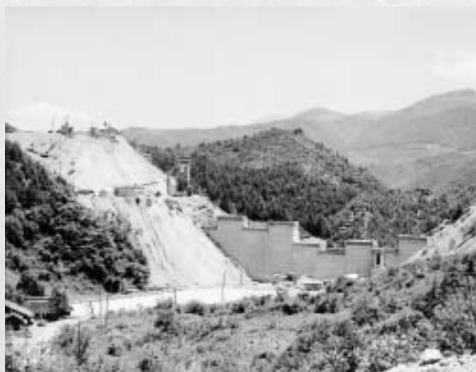
建設途中の菅平ダム。昭和24年に神川総合開発の一環として企画されたのが、計画の始まりだった。
