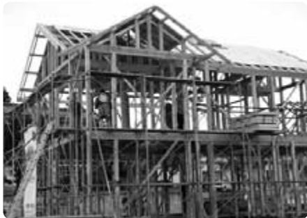
新築される住宅
