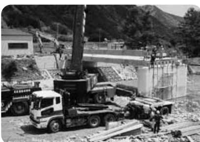
大きなクレーンで吊り上げられた橋げた(上小寺尾橋)
