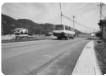
水路の整備もされた上武石・沖線
