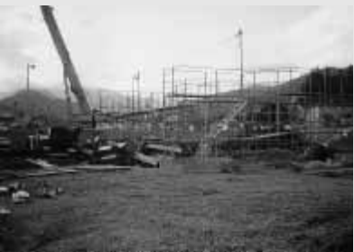
建設中の福祉企業センター
