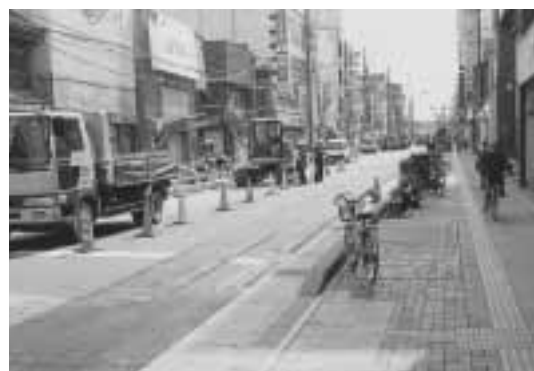
◀ 今電線共同溝事業が進む海野町通り、その後アーケードが設置される
