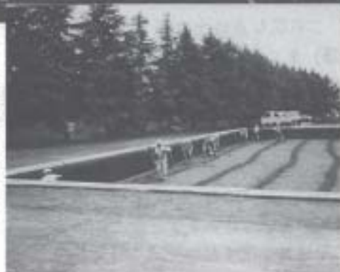
▲染屋浄水場のろ過池 (汚砂の取り取り作業)
