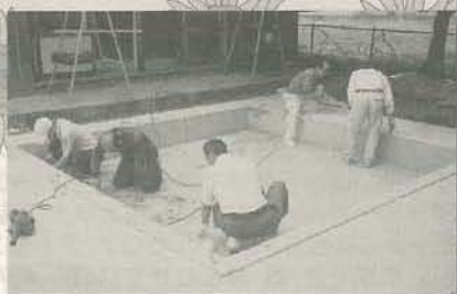
補修前(作業中)
