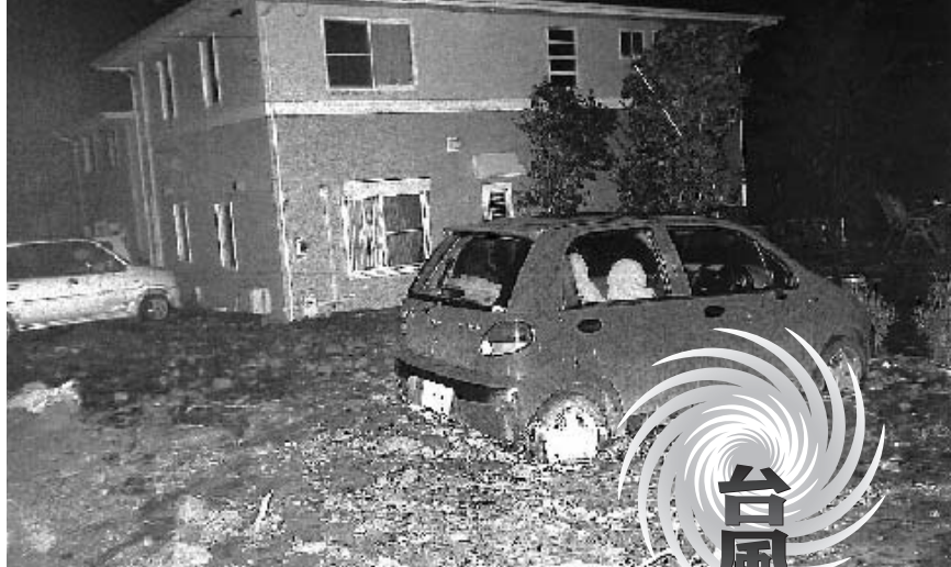
住宅の裏の造成地が崩れる—新田地区
