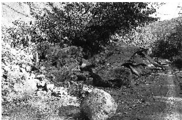
県道真田東部線の土砂崩れ—岩清水地区
