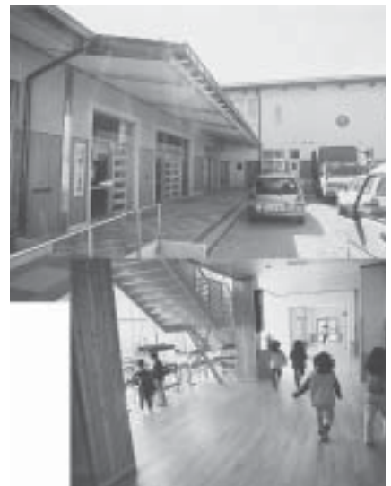
改築された城下小学校
