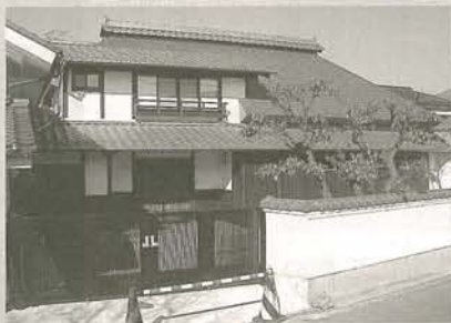
① 池田宅 (築地284) 【民家再生住宅】
