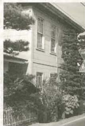
建物外観(南西から)
