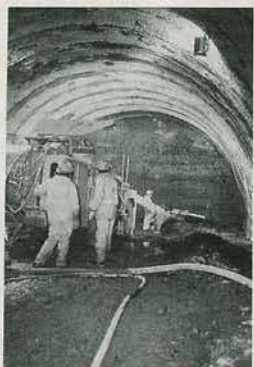
→北陸新幹線丸子トンネルの工事
