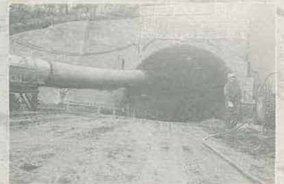
丸子トンネル坑口
