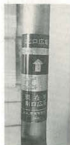
↑点字の手すり。 目の不自由な人 にも優しい配慮 が
