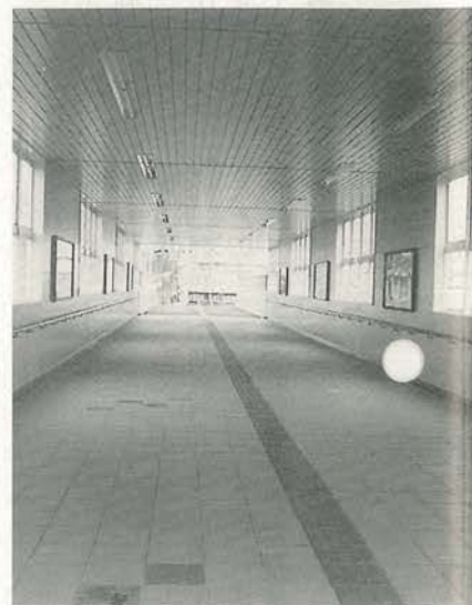
↑連絡橋の内部。幅は 6メートル
