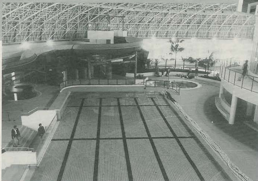
↑アクアプラザ内部の様子。 手前が深さを調節できる25 メートルプール
