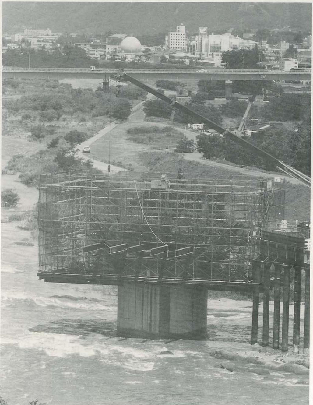
←第二千曲川橋りょうで、主塔の土台となる部分。主塔は高さ六十五メートル、橋の両側に太さ十センチのケーブルを十一本ずつ張る
