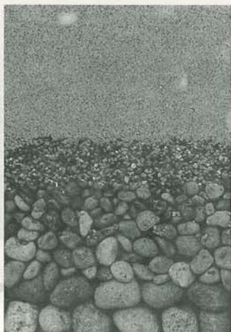
染屋浄水場緩速ろ過池の断面
