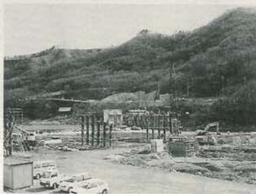
新幹線千曲川第2橋りょうの工事
