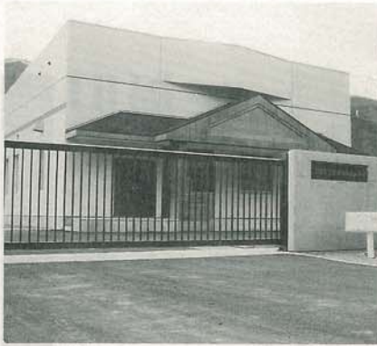
昨年11月に完成した下塩尻ポンプ場
