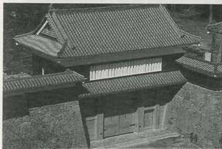
↑市民会館屋上からの櫓門
