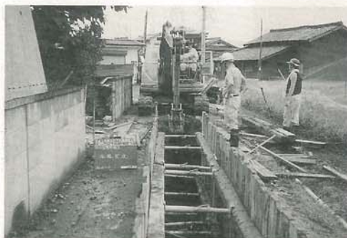
各地で下水道管の布設工事が行われています
