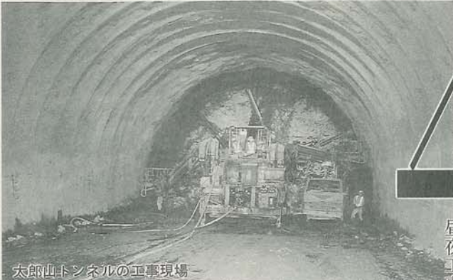
太郎山トンネルの工事現場
