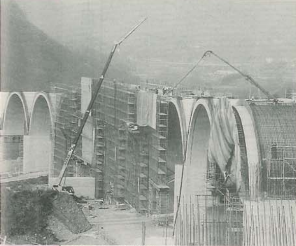
20個のアーチが連続する上信越自動車道神川橋(仮称)
