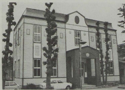
改修なった市役所分室
